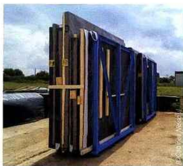
Les façades-manteaux sont préfabriqués en atelier, conditionnés en "racks" et approvisionnés directement sur le chantier.
