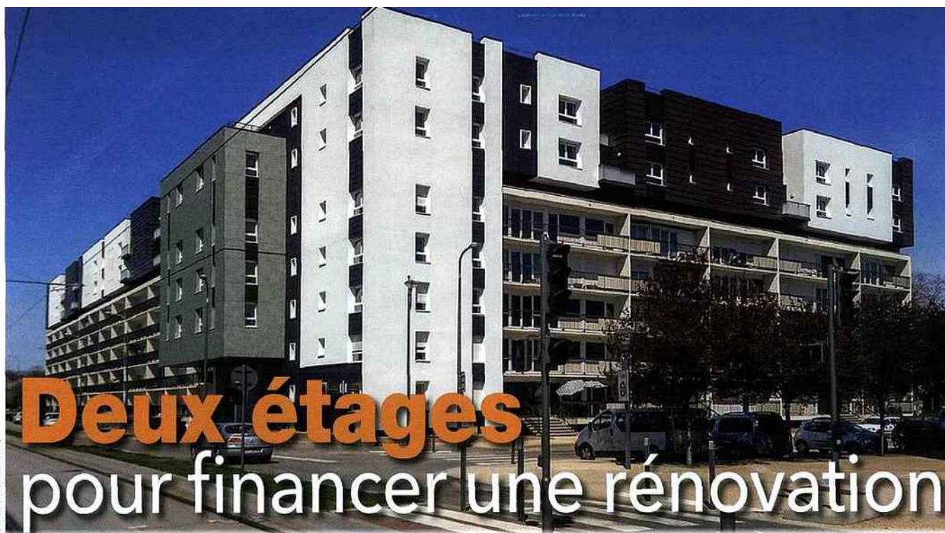
La surélévation terminée. Les parties nouvelles et anciennes restent parfaitement identifiables.
