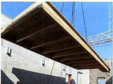
Les caissons de toiture, supports d'étanchéité prennent appui sur les façades-manteaux.
