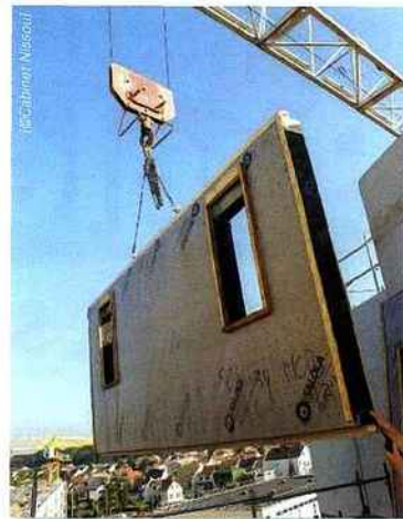
Les façades sont levées à l'aide d'une grue et liaisonnées aux dalles béton, réalisées par l'entreprise de gros-œuvre.
