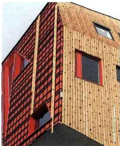
Salola lance une nouvelle membrane d'étanchéité couleur perméable à la vapeur d'eau, imperméable à l'eau et résistante aux UV. Disponible dans un large choix de coloris Ral, elle permet de jouer avec les couleurs, la profondeur des façades et les
